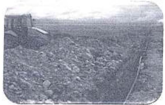
Instalación tubería HDPE-Sifon Invertido
